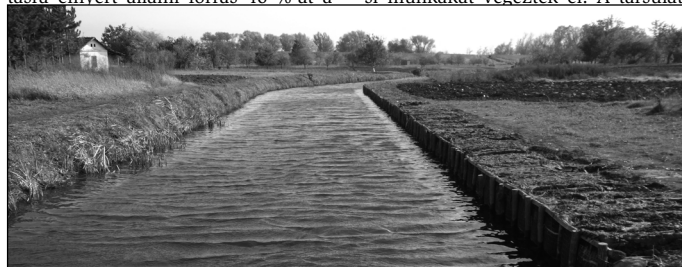
Mezőtúr XIII. csatorna (Holt-Berettyó) rekonstrukciója
